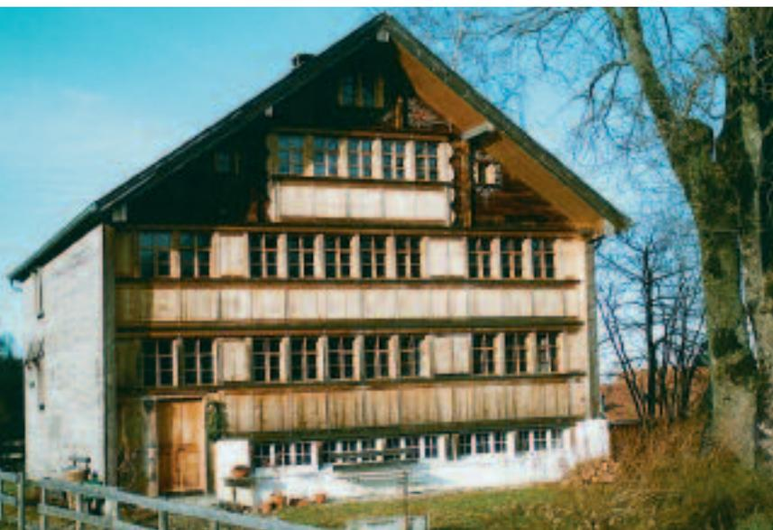
Die geschlossenen, einfachen Hauptbaukörper weisen eine rechteckige Grundrissform auf, was sich aus der herkömmlichen Strickbauweise mit Wänden aus kantigen, an den Ecken "gestrickten" Balken und mehreren kleinen Fensteröffnungen ergibt. Diese konnten mit Läden verschlossen werden. Später entstanden Aussenwandverkleidungen aus Brettern, Schindeln oder Täfer. Die Merkmale der traditionellen Verkleidung sollen weiter gepflegt werden.
