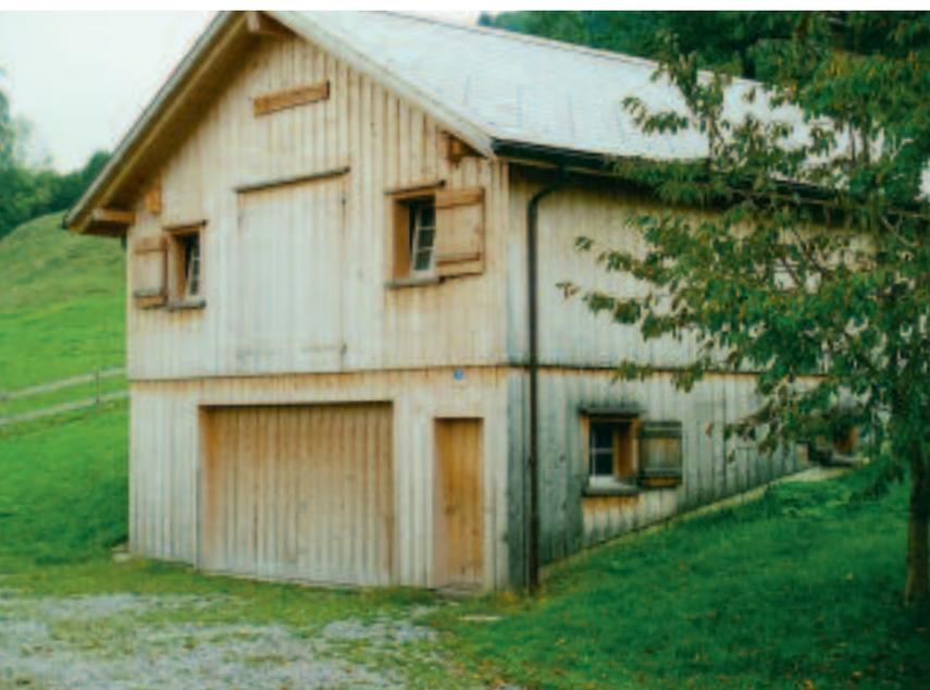
Tore sind (wie bei alten Scheunen) mit einem Holzleistenschirm zu verkleiden und falls möglich, aussen bündig anzuschlagen. Unter Einhaltung dieser Regel sind auch Kipptore denkbar.
