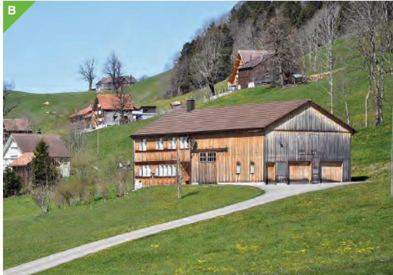
Abb. 21: Bei diesem Neubau konnten für die Garageneinfahrten durch leichtes Abtragen des Terrains Mauern vermieden werden.
