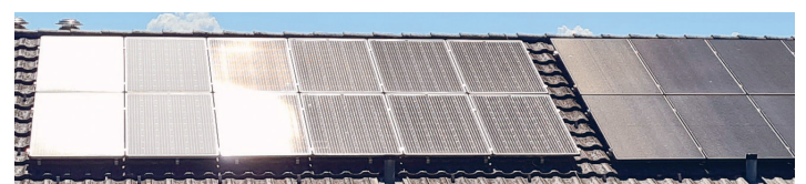
Abbildung 6: Blendung auf dem Standard-Modul, nicht jedoch auf dem Modul mit Folie (Quelle: Fussnote 3).
