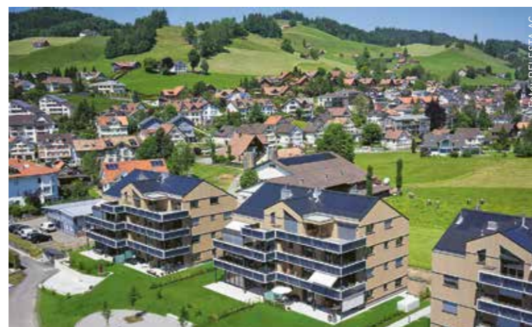
Überbauung Rotbach in Gais
