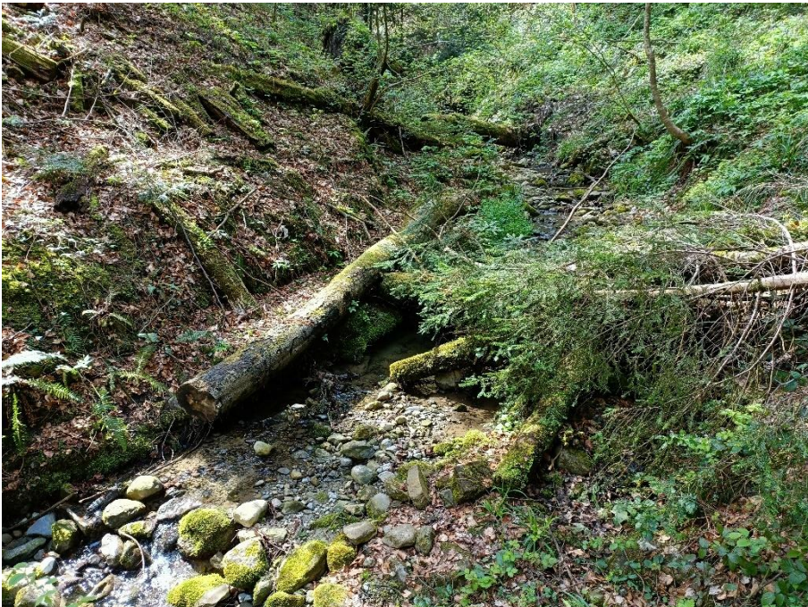
Abbildung 16: Büelbach ca. 40m oberhalb Einlaufbauwerk
