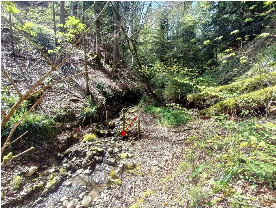
Abbildung 14: Blick vom Einlaufbauwerk auf Überlauf. Markiert ist der Schwemmholzrechen.
