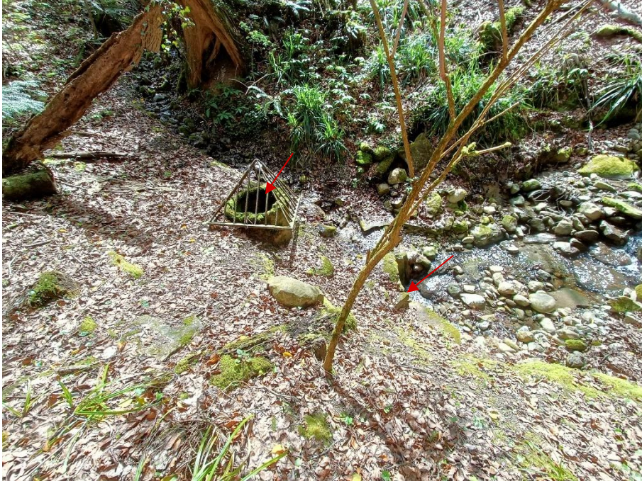
Abbildung 13: heutiges Einlaufbauwerk (2 Einläufe) mit pyramidenförmigem Überlauf
