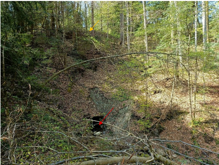
Abbildung 21: Ansicht Auslaufbauwerk (im Hintergrund oben befindet sich die Bahnlinie, orange markiert)
