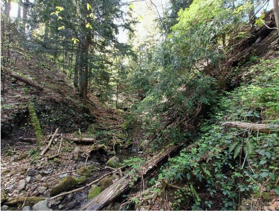
Abbildung 17: Büelbach ca. 100 m oberhalb Einlaufbauwerk
