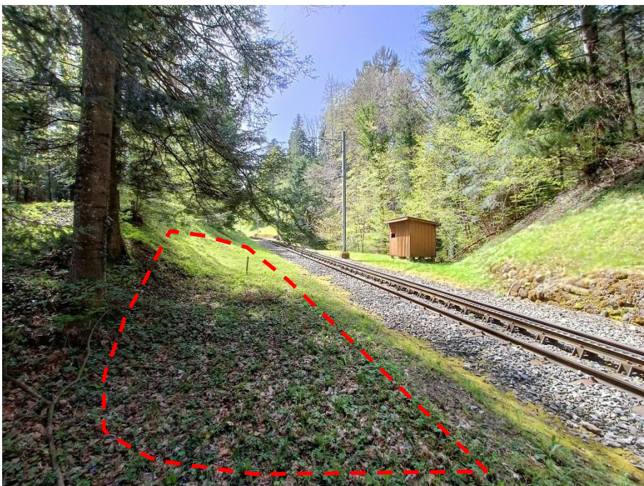
Abbildung 12: Blick in Richtung Heiden, seitliche Materialdepots ostseitig entlang Bahnlinie
