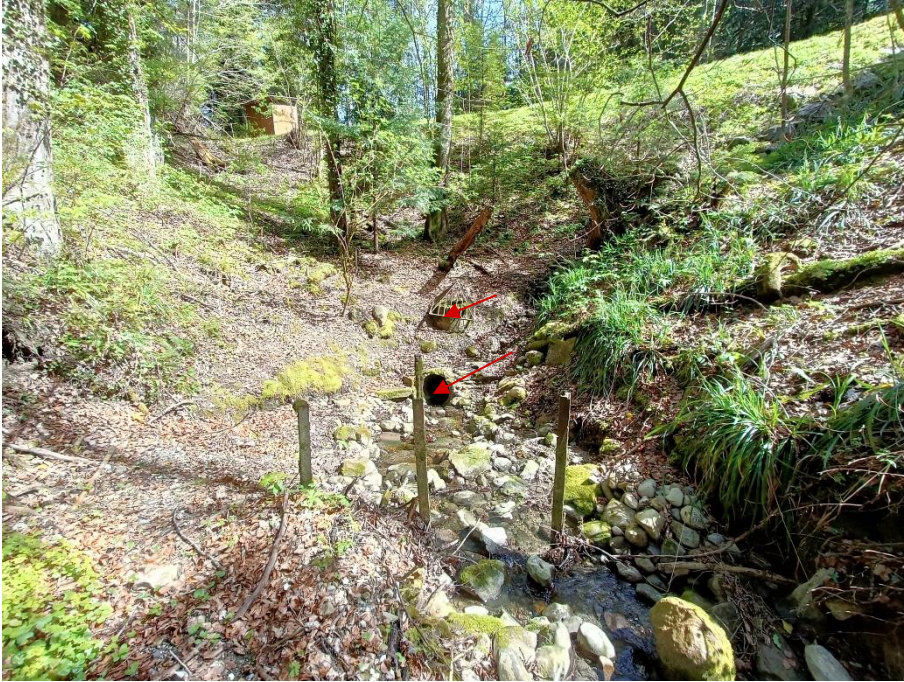
Abbildung 15: heutiges Einlaufbauwerk. Im Hintergrund oben befindet sich das Bahnwärterhaus sowie die Bahnlinie.
