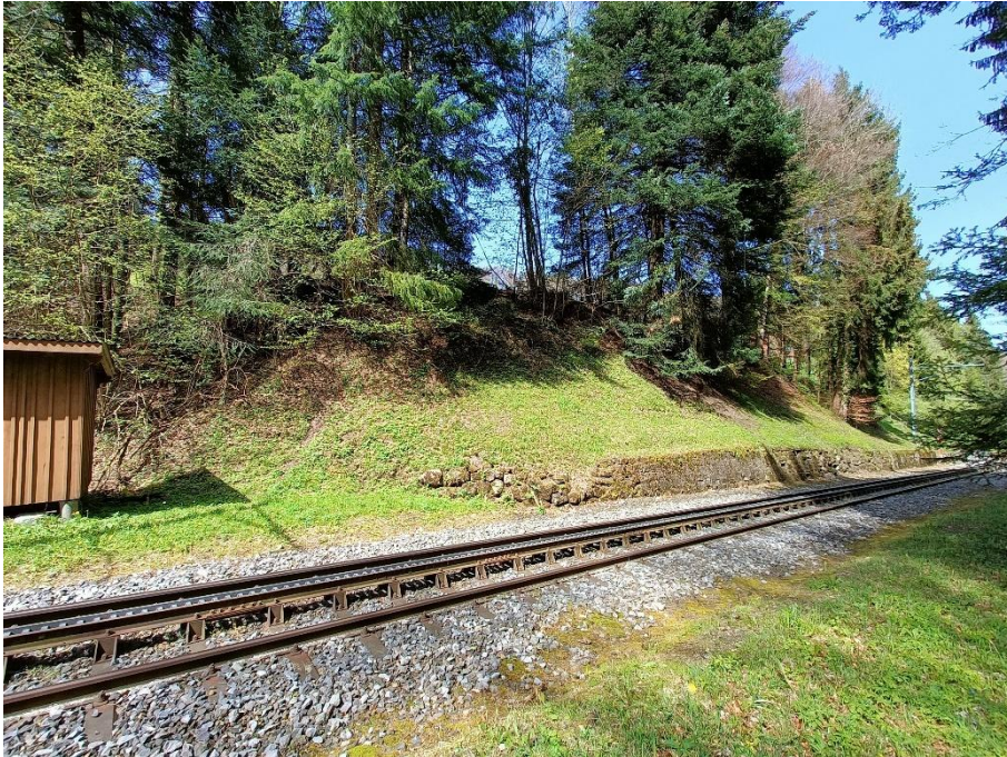
Abbildung 11: Ansicht westseitig, Abbruch Gebäude für Bau Interventionspiste
