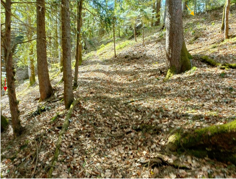
Abbildung 26: Hang talseitig Bahnlinie zu Auslaufbauwerk, rot markiert (Materiallieferung Blocksteine, Zufahrt Schreitbagger), Bahnlinie orange markiert
