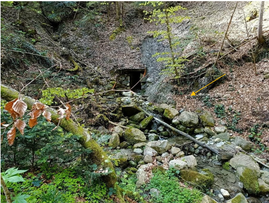
Abbildung 23: Auslaufbauwerk bestehend und ungefährer Standort neuer DL (orange)
