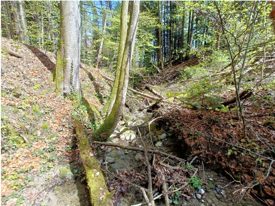
Abbildung 24: Büelbach ca. 40 m unterhalb Auslaufbauwerk
