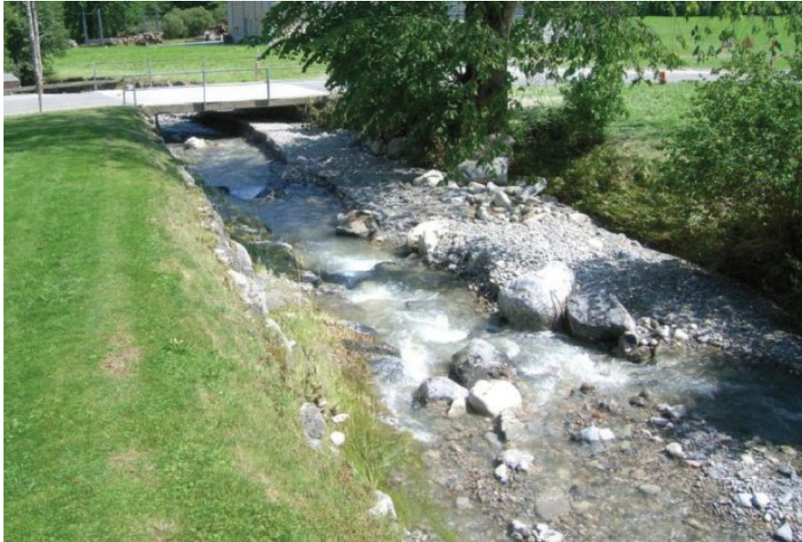
Geschiebeablagerungen im Egglibach nach Hochwasser 2011
