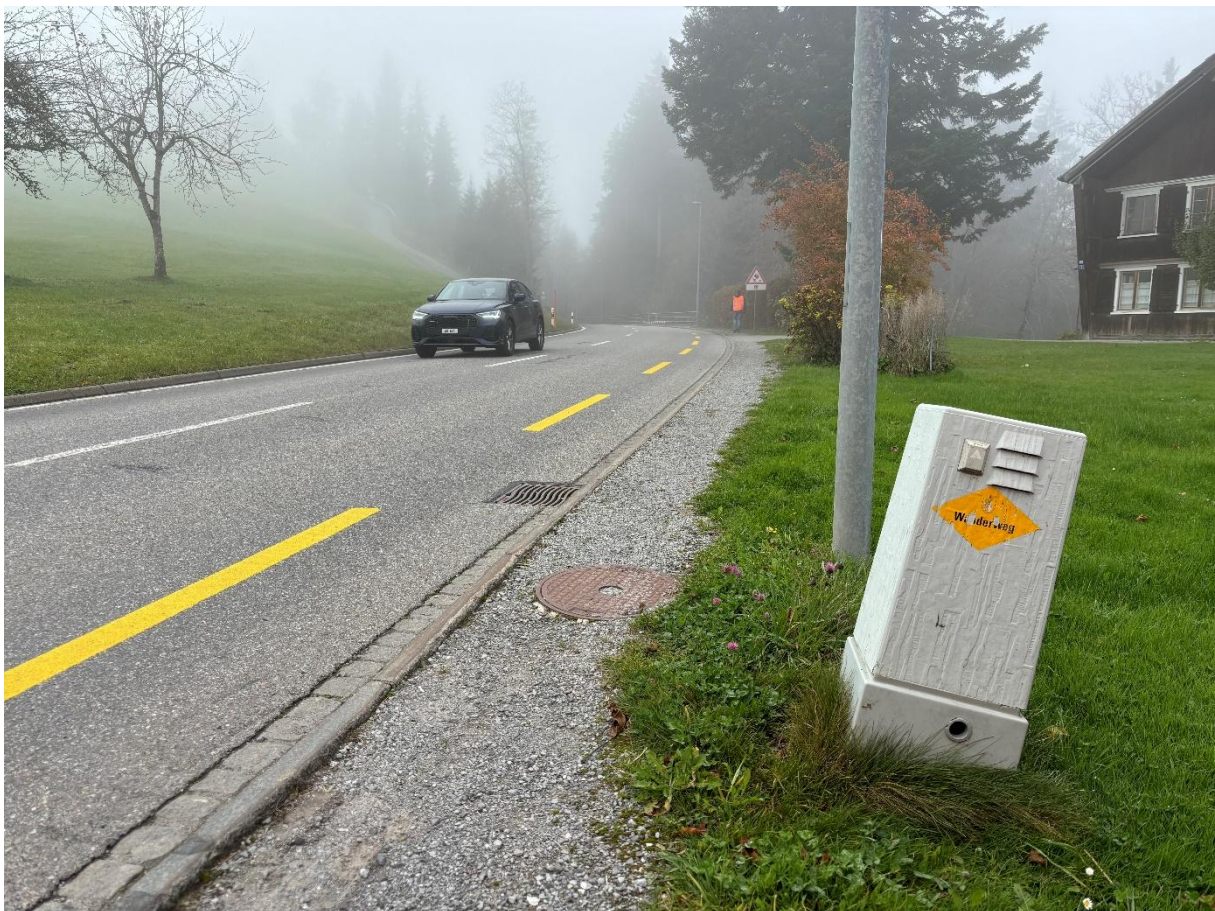
Abbildung 5: Einseitig vorhandenes schmales Bankett entlang der Kantonsstrasse mit einem Wanderweg
