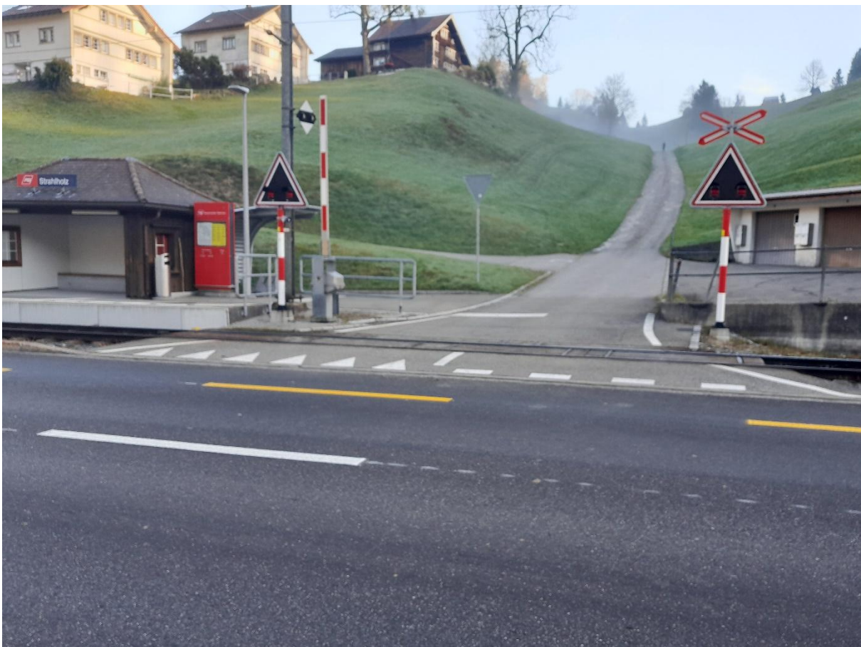
Abbildung 10: Querung mit unklarer Fussgängerführung
