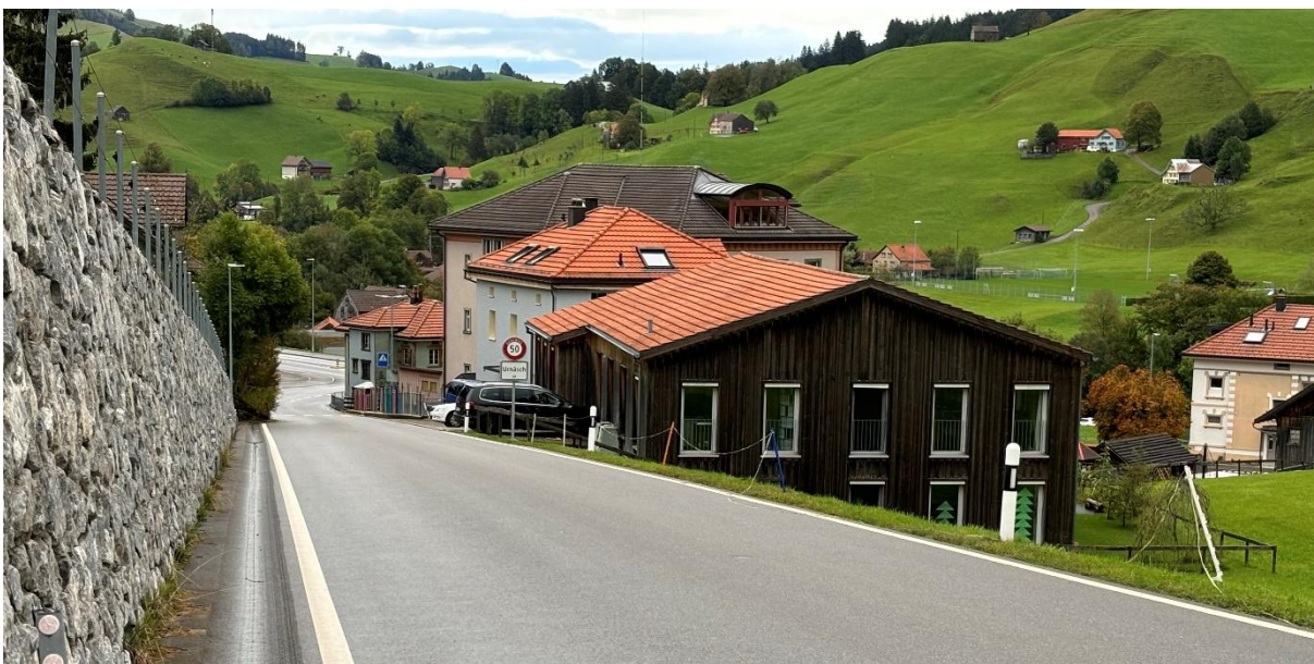
Abbildung 6: Kantonsstrasse mit einseitig vorhandenem, aber als Entwässerungsrinne ausgebildetem Bankett
