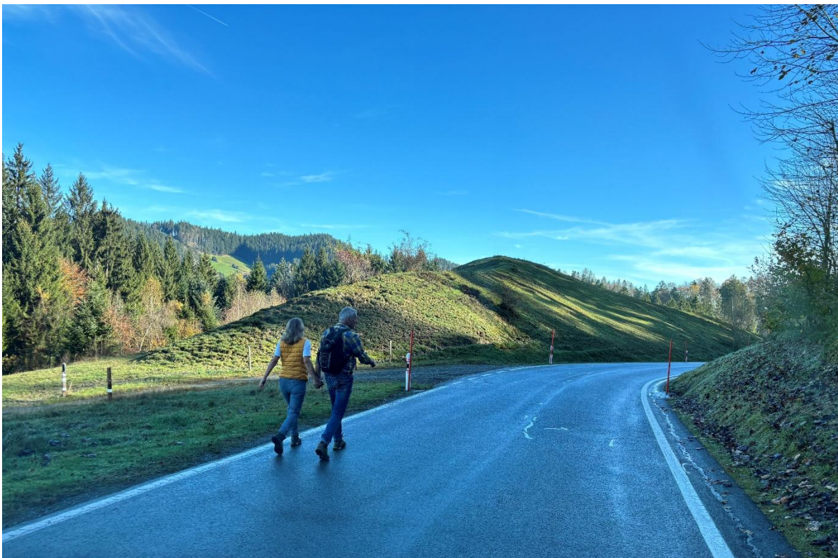
Abbildung 4: Auf der Kantonsstrasse verlaufender Wanderweg beim Ruppenpass ohne genügend breites Bankett
