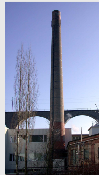
Die Mobilfunkantenne an einem Hochkamin in Herisau
