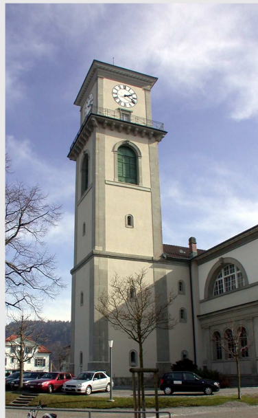
Für den Kirchturm Heiden liegt ein Antennenprojekt vor.
