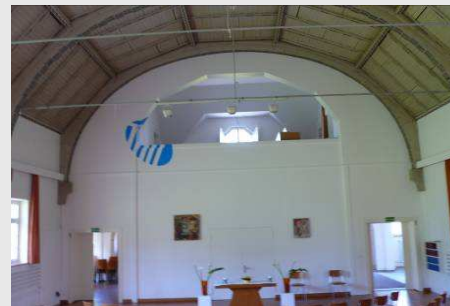
Ansicht Empore, Zustand vor Sanierung 2009
