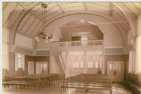
Ansicht Empore, Zustand 1909
