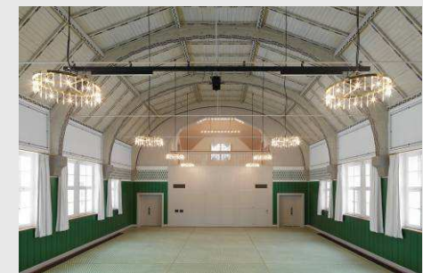
Ansicht Empore, Zustand nach Sanierung 2009
