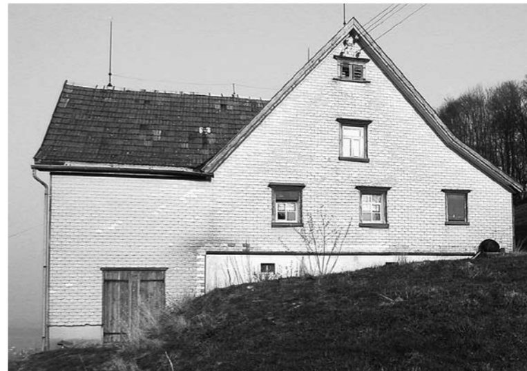
Die Westfassade eines Bauernhauses im Appenzeller Vorderland ist nur durch sparsam gesetzte Fensteröffnungen durchbrochen.
