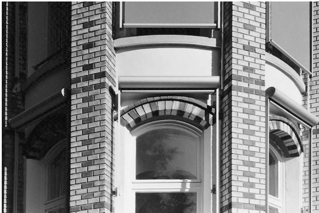
Fassadenausschnitt Villa Nieschberg, Ass. Nr. 2346, Herisau. Erbaut 1908/09 von Baumeister H. Grunwald aus Köln für den Textilgrosskaufmann Ernst Buff. Das Dach und die Sichtbacksteinfassade wurden 2005 saniert, die Fenster mit einem neuen Sonnenschutz versehen.
