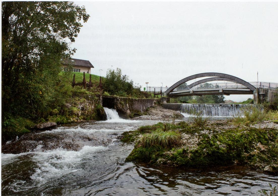
Hintereggbrücke mit Wehr der Wasserfassung für die Turbine der Zwirnerei in der Heide.
