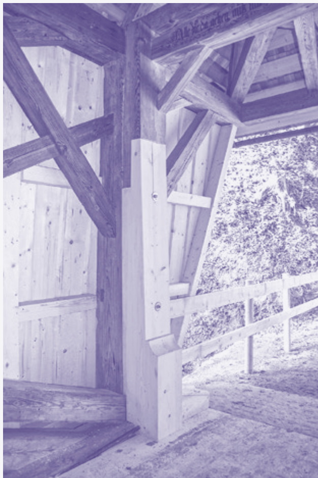
Reparatur und statische Ertüchtigung an der Grubenmann-Brücke von 1778 über die Urnäsch zwischen Hundwil und Herisau aus dem Jahr 2014 sind deutlich zu erkennen. Die statische Nutzlast-Berechnung und das Reparaturkonzept erfolgten durch den 2022 verstorbenen Holzbauingenieur Paul Grunder.
