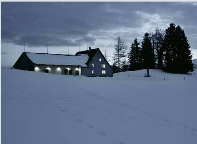
Die Wetterfassade, hier nach Nord-Nordwest ausgerichtet, ist geschlossener als die anderen. In der Regel befinden sich auf dieser Seite die Nebenräume.
