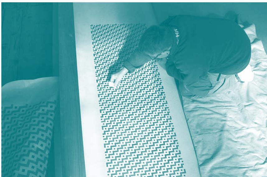
Probedruck mit Blechschablone auf Papier für den zweifarbigen, in Holzzement gegossenen Boden.
