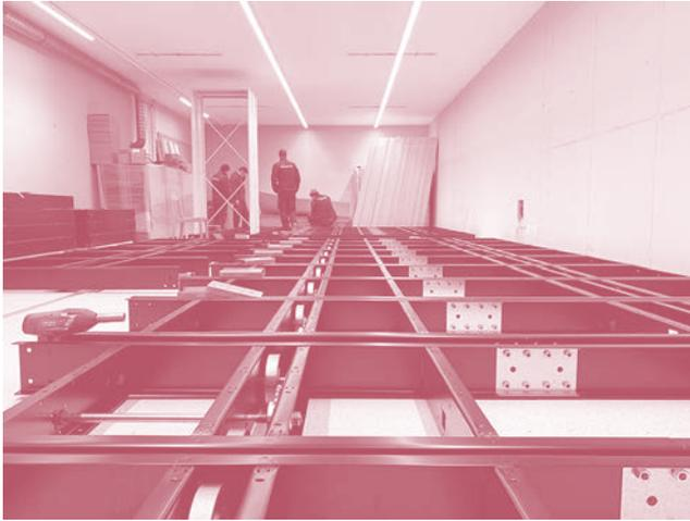
Einbau einer Compactus-Anlage mit tausend Regalmetern in der Zivilschutzanlage Hinterdorf in Trogen.
