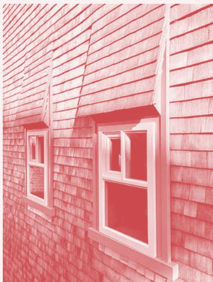
Oben: An einer Nordfassade in Trogen wurde die Fassade mit neuen Vorfenstern aus Holz versehen und saniert.
