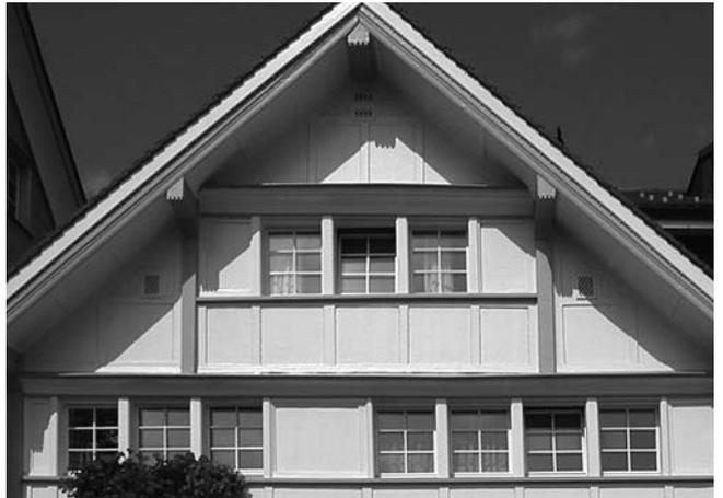
«Sekundärbauteile der Verkleidung werden durch Witterungseinflüsse abgenutzt und müssen ersetzt werden. Bei dieser Gelegenheit können aktuelle Stileinflüsse aufgenommen und ins Gebäude integriert werden.»
