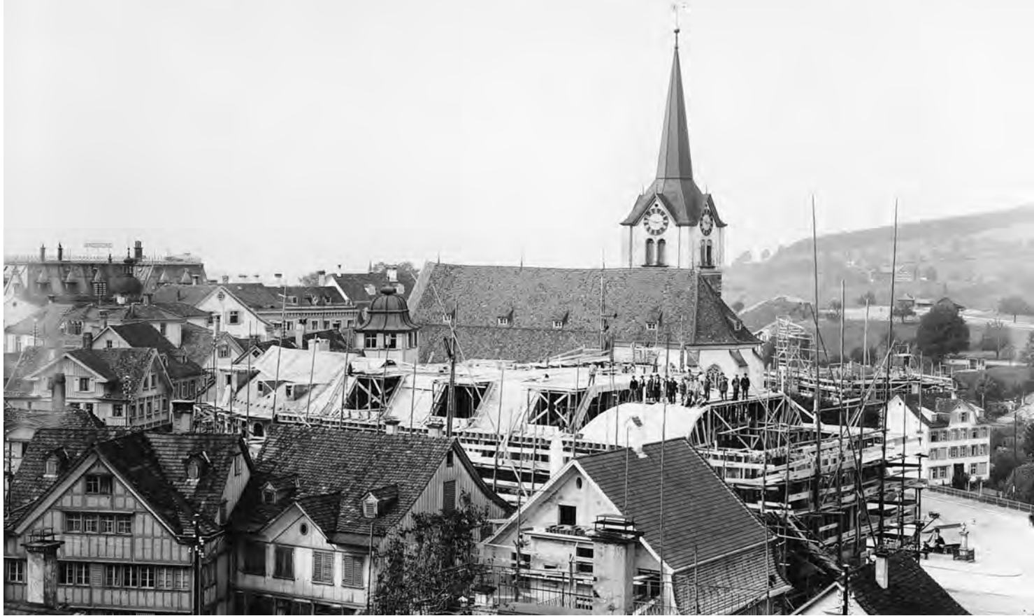
Kantonbankgebäude Herisau, Bau der Betondecke
