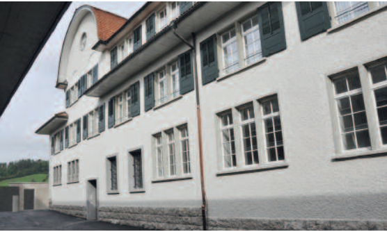
Hoffassade Haftzelle Polizeigarderoben
