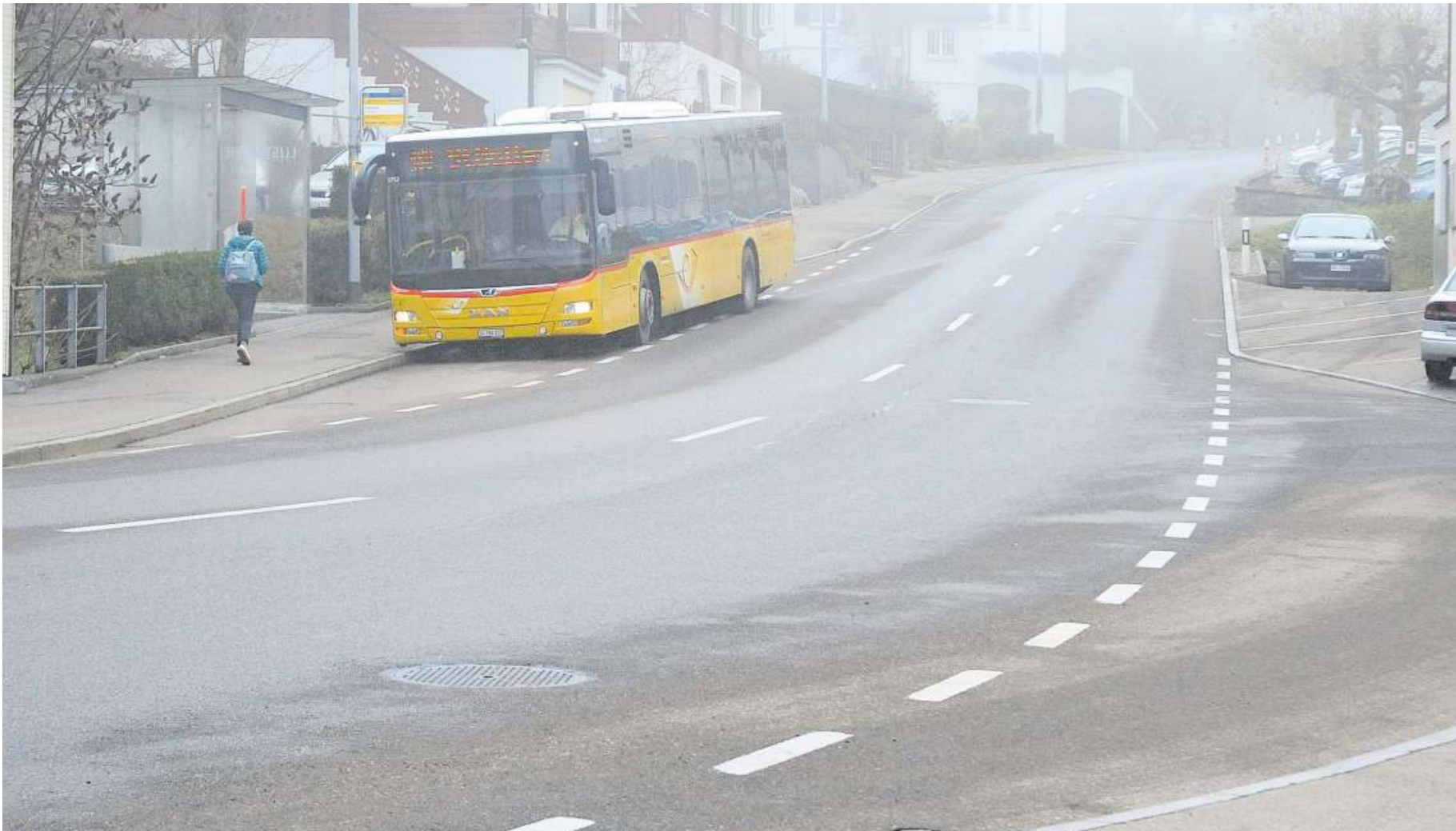
Hier bei der Haltestelle Lustmühle soll die Buswendeschleife erstellt werden. Möglicherweise befahren diese dann zwei Busse pro Stunde.
