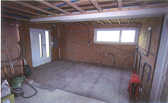
Anbau neu; Eingang/Küche
