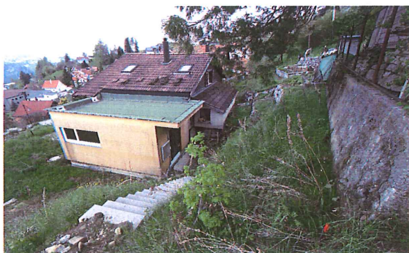
Fassade Ost, Dach
