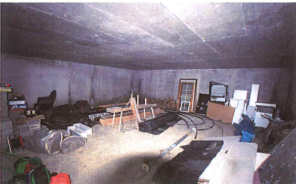
Abstellraum 2.UG, Doppelgarage
