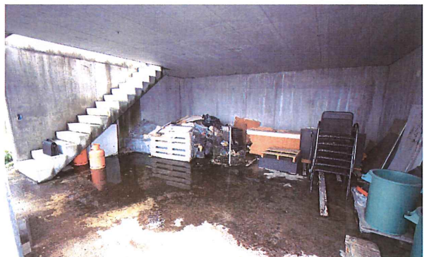
Abstellraum 1.UG, Doppelgarage
