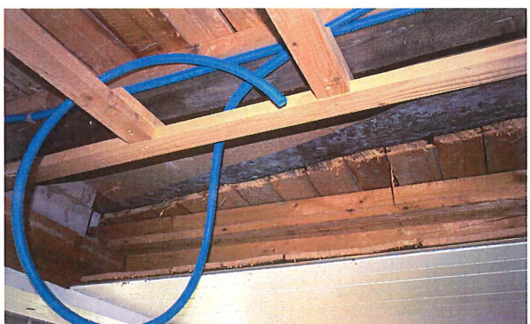
Decke EG mit altem Blechdach
