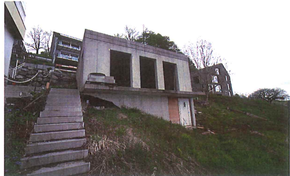
Fassade Süd Rohbau Doppelgarage
