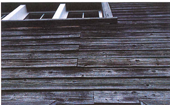
Schalung Fassade Süd
