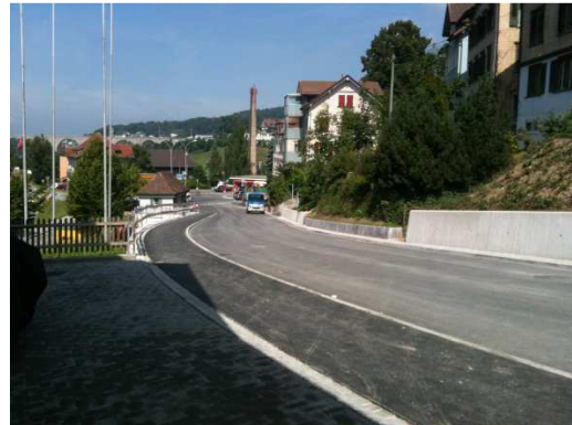
Bild 6: untere Steig, Herisau: Ausbau mit Trottoir
