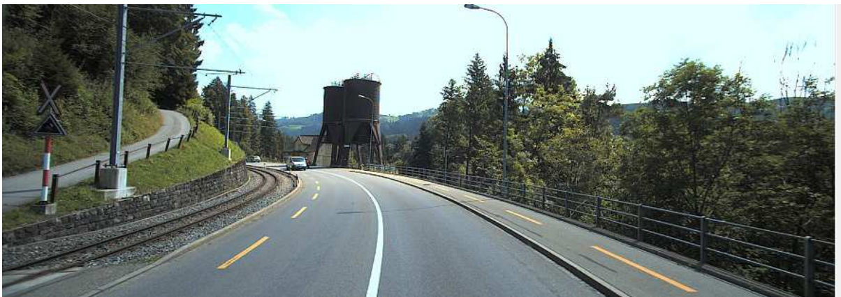
Bild 21: Längerfristiger Bedarf auf der Kantonsstrasse Nr. 12.5, Teufen - Bühler; Instandsetzung der Hangbrücke Strahlholz, Baujahr 1938, erste Sanierung 1980. Das Trottoir rechts ist auf einer Kragkonstruktion, die besonders witterungs- und somit korrosionsanfällig ist.
