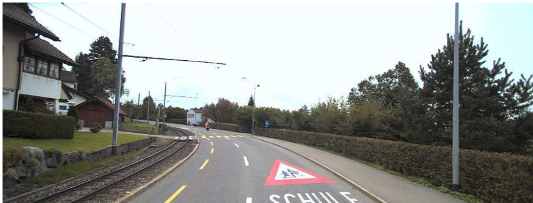
Bild 11: Ortsdurchfahrt Niederteufen: der Handlungsspielraum für gestalterische Massnahmen ist wegen der Bahn gering.
