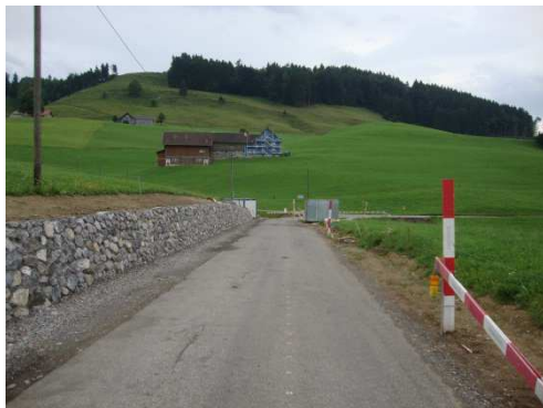
Bild 7: Munitionsdepot - Aeschen, Hundwil: Ausbau
