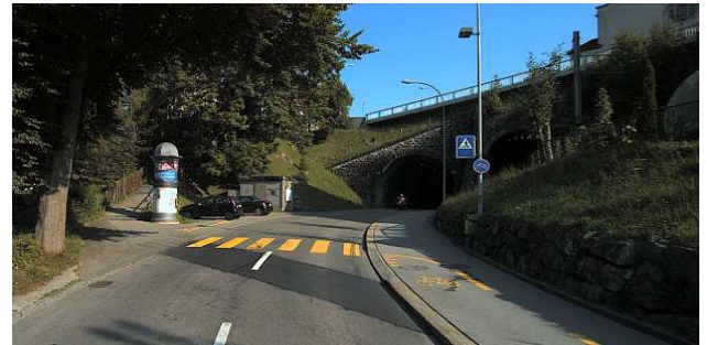
Bild 15: Mühlestrasse Herisau: es ist nicht möglich, den kombinierten Rad- Gehweg durch den Tunnel zu ziehen. Die Schwachstelle bleibt vorerst.
