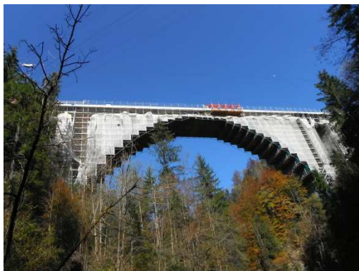
Bild 5: Stein / Teufen, Gmündertobelbrücke: Sanierung
