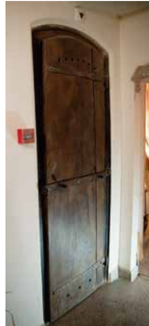
Abb. 37: Türe zum ehemaligen Dunkelarrestlokal.
