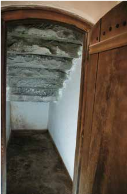
Abb. 36: Ehemaliges Dunkelarrestlokal unter der steil abfallenden Treppe; heute als Abstellkammer genutzt.
