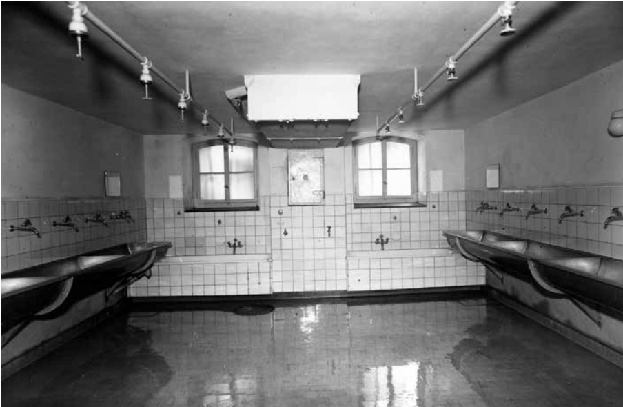
Abb. 32: Der Dusch-, Bade- und Waschraum nach dem Umbau von 1945/46, um 1946. Die Waschküche war nun separat untergebracht und die Verwalterwohnung mit einem eigenen Badezimmer ausgestattet worden.
