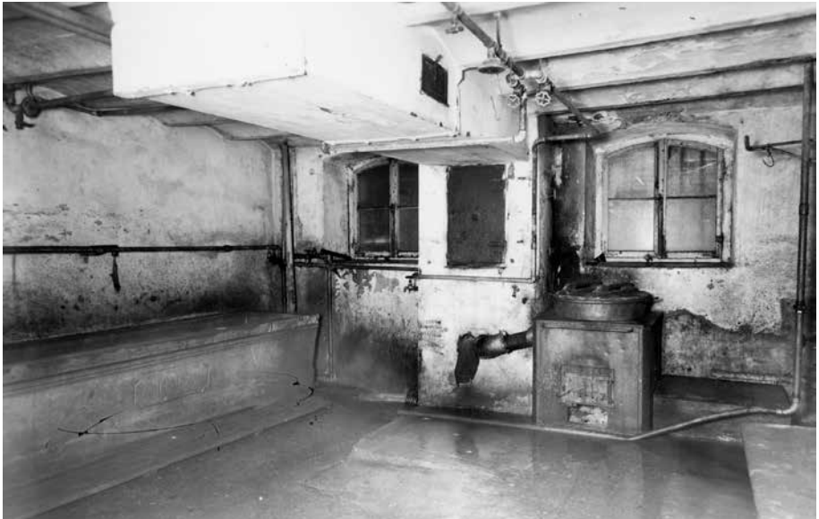
Abb. 31: Der alte Wasch- und Baderaum vor dem Umbau, um 1940. Die Waschküche und die Badeeinrichtung waren in einem Raum untergebracht.
